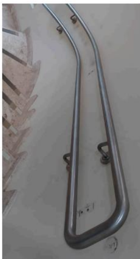
Guarda corpo em Gradiil em tubo de aço inox ø=1" a cada 10cm, com montantes lãgangeado em tubo inox ø=2" e com fechamento em tubo ø=2", com acabamento polido, h=1,20m, inclusive chumbador parabolê de 1/4", com corrimão duplo m tubo inox ø=1 1/2".
