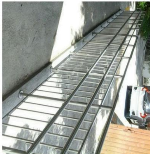
Guarda corpo em Gradiil em tubo de aço inox ø=1" a cada 10cm, com montantes lãgangeado em tubo inox ø=2" e com fechamento em tubo ø=2", com acabamento polido, h=1,20m, inclusive chumbador parabolê de 1/4", com corrimão duplo m tubo inox ø=1 1/2".
